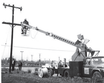
Fig. 11 – Uma das plataformas elevatórias já ao serviço da empresa de electricidade.
