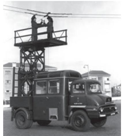
Fig. 3 – Carro Torre dos STCP na reparação de linhas eléctricas na cidade do Porto na década de 1960.
