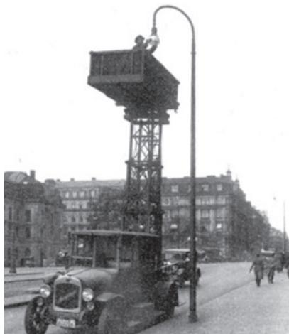
Fig. 2 – Uma versão de 1929 na substituição de lâmpadas na via pública na Suécia.
