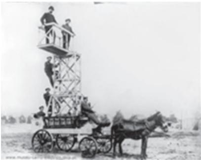
Fig. 1 – Carro Torre dos STCP na reparação de linhas eléctricas na cidade do Porto na década de 1960.
